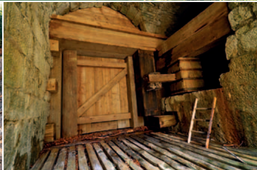
Klavžna vrata z mehanizmom za odpiranje
